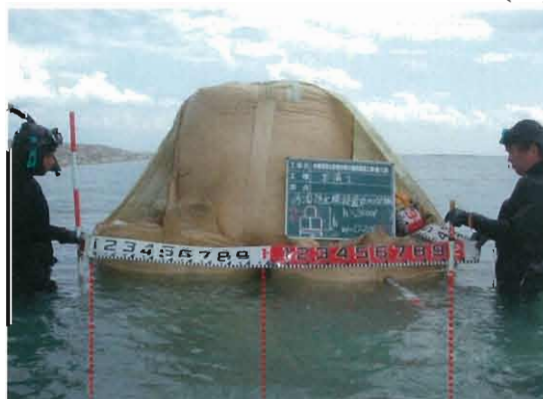
大型土嚢汚濁防止膜設置
