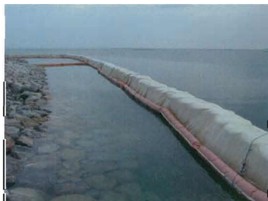
大型土嚢汚濁防止膜設置完了
