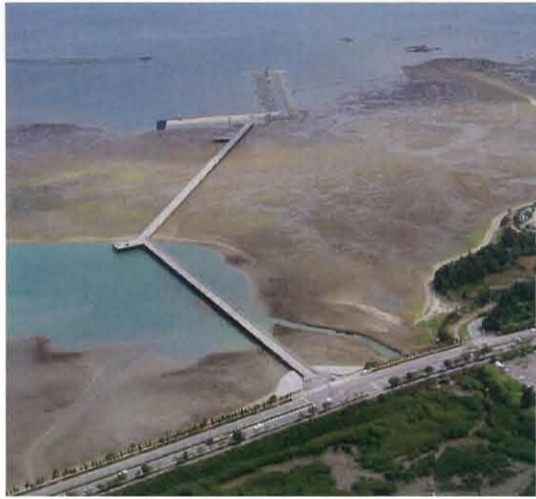
【 ①仮設橋梁全景 】
