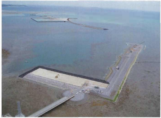
【 ②仮設橋梁先端 】
