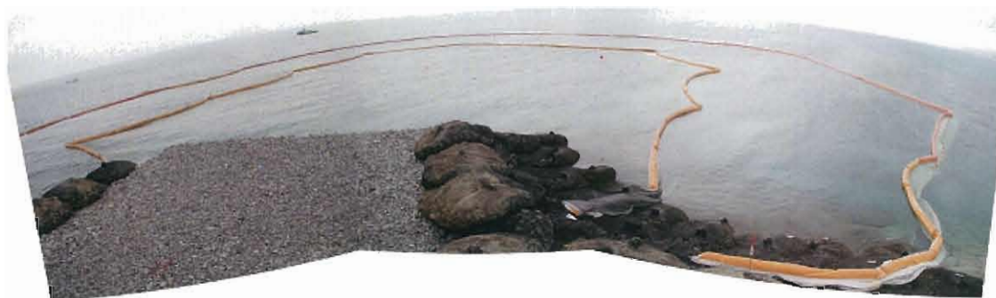
汚濁防止膜設置
