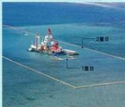
汚濁防止膜(二重敷設)
