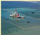
汚濁防止膜(二重設置)
