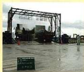
石材の洗浄の様子
