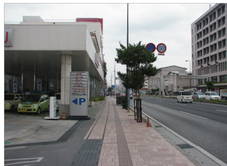
浦添地区電線共同溝 (浦添市)
