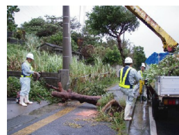
復旧作業（風倒木処理）
