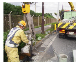
構造物の補修
