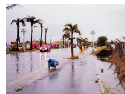
台風による災害状況
