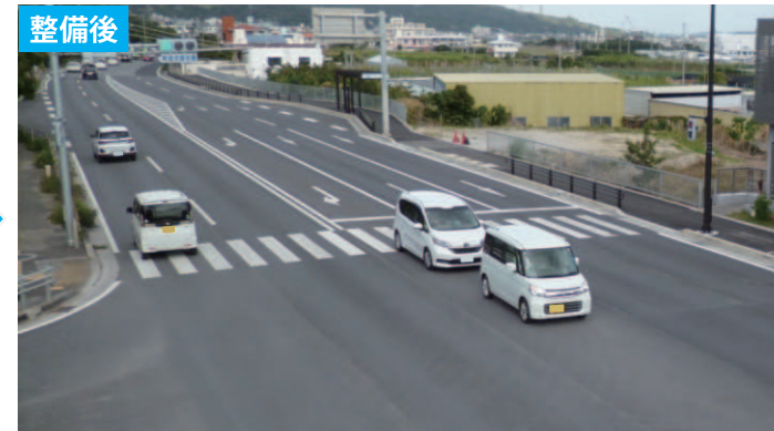
施工完了（右折車線の新設、バス停車帯の設置）
