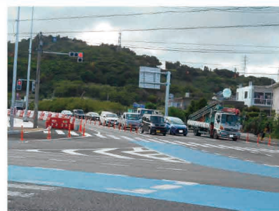
令和3年度開通区間（与那原(北)交差点付近）
