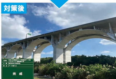
国道506号南風原アーチ橋（南風原町宮城）耐震補強
