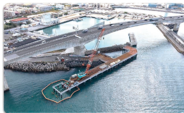
仮橋施工状況
