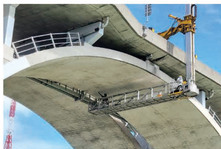
南風原アーチ橋 橋梁点検
