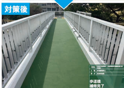
国道329号宮里歩道橋（沖縄市宮里）歩道橋補修
