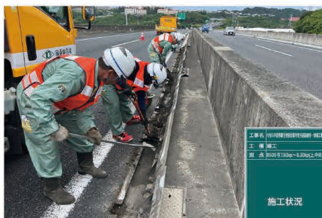
令和5年度那覇空港出張所管内道路維持・修繕工事 側溝清掃
