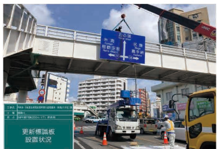
令和4・5年度与那原出張所管内道路維持・修繕（その1）工事 案内標識更新
