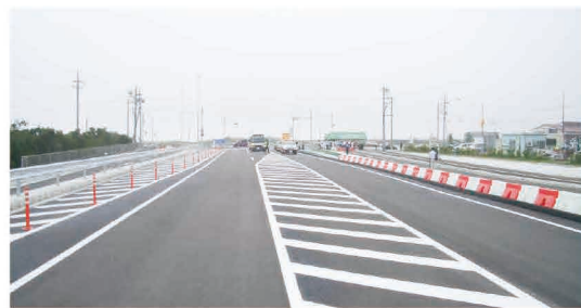
読谷道路 平成25年度 開通区間
