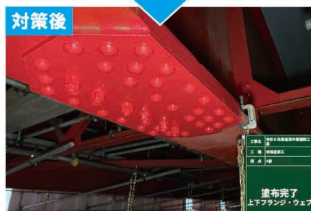
国道330号浦添大橋（浦添市大平）橋梁補修
