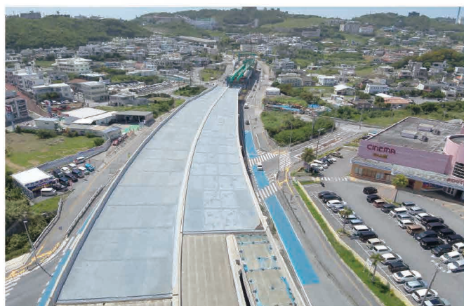
南風原バイパス 令和5年5月24日 撮影
