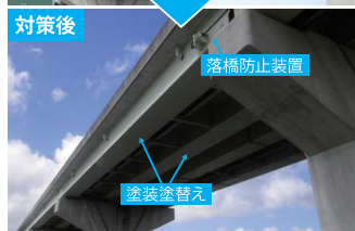
国道 506 号宮城高架橋（南風原町） 補修（塗装塗替え）・補強（落橋防止システム等）
