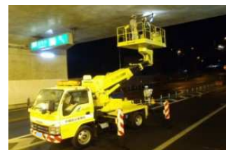
トンネル点検車
