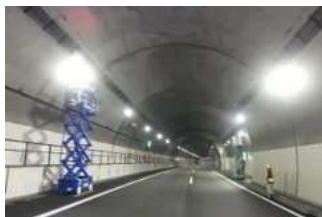
不灯箇所の機器点検や灯具取替え
