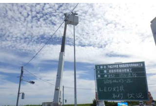
不灯箇所の機器点検や灯具取替え
