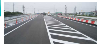
読谷道路 平成 25 年度 開通区間
