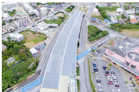
南風原バイパス 令和3年10月18日撮影
