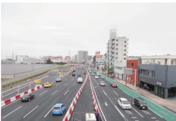
浦添拡幅 令和3年度暫定8車線開通
