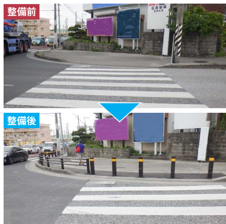
防護柵設置（沖縄市沖縄北IC交差点）
