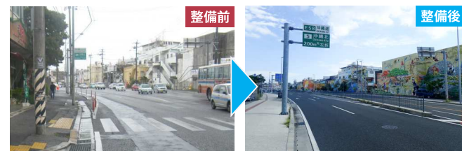
電線共同溝の整備事例（沖縄市コザ十字路）
