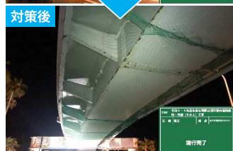
落下防止ネットの設置
