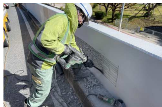
高架橋高欄補修
