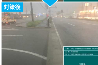
大雨による冠水被害の応急処理
