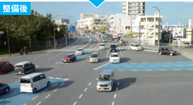
交差点改良〔車線分離標、路面標示、左折専用車線〕 （北中城村ライカム交差点）
