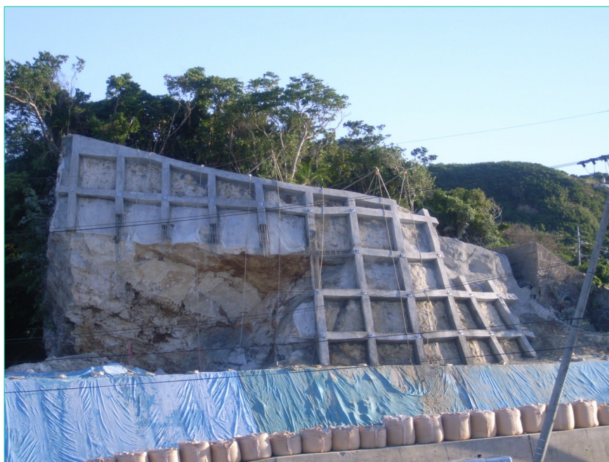
④法枠・ロックボルト完了(平成20年11月現在)
