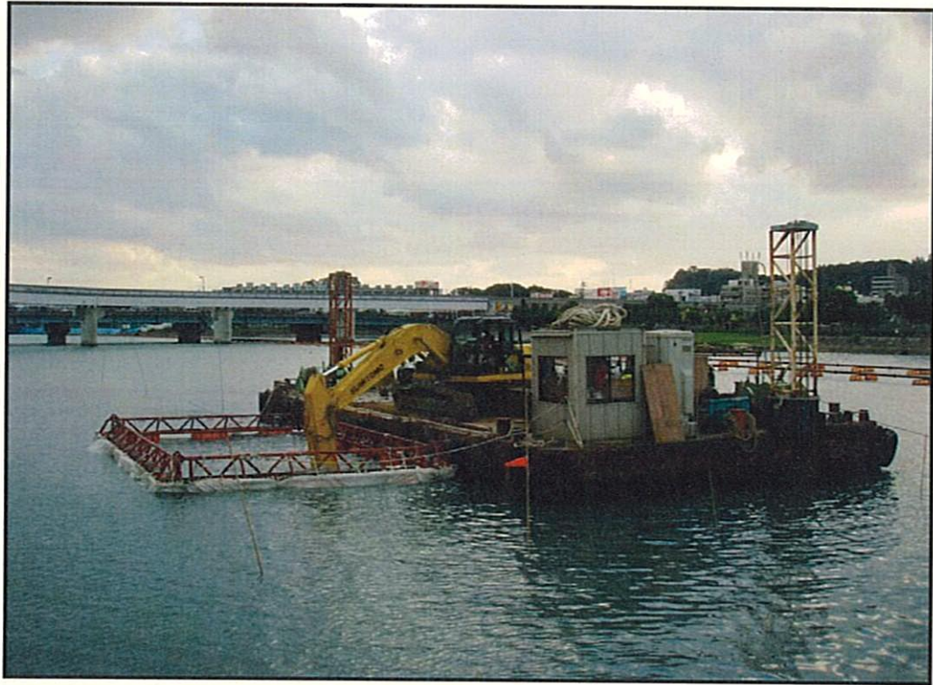
【バックホウ付台船 施工状況②】
