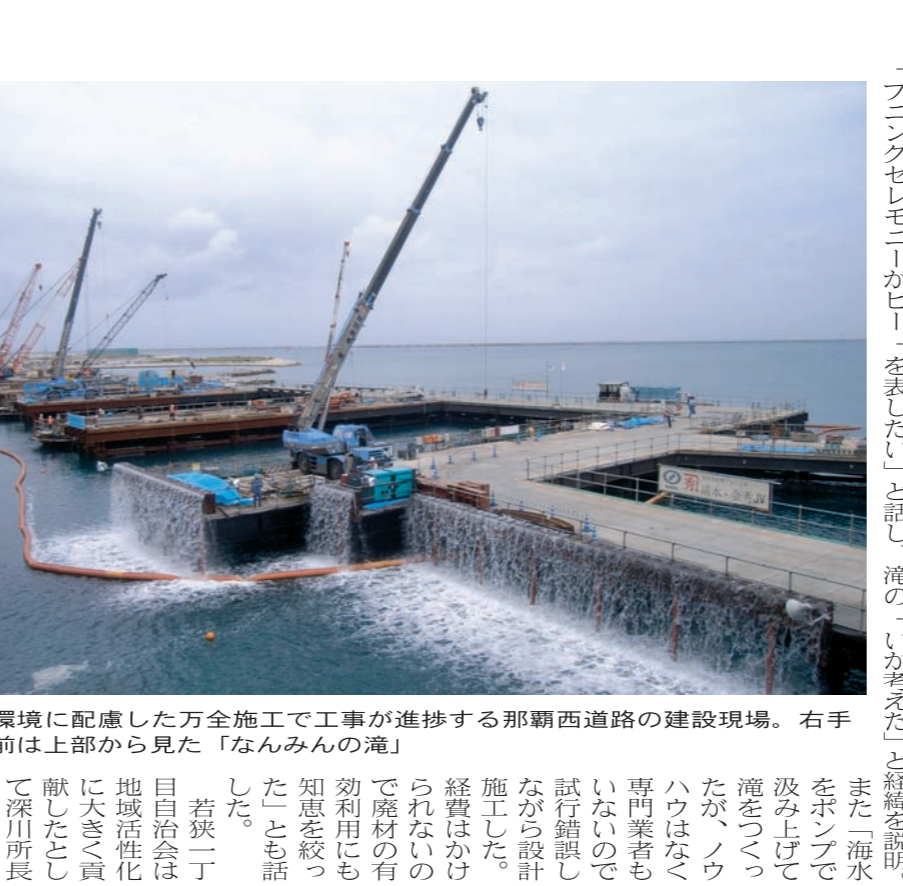
環境に配慮した万全施工で工事が進捗する那覇西道路の建設現場。右手前は上部から見た「なんみんの滝」
