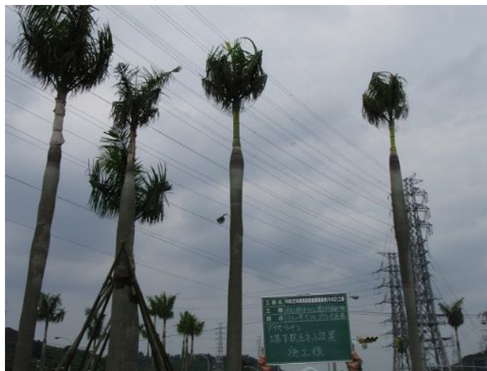
ネット施工状況
