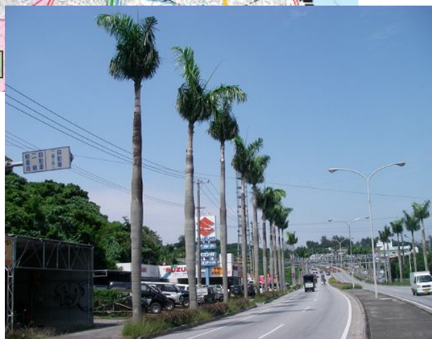
ネット施工区間
