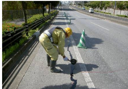
【補修作業状況】
