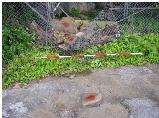
【法面転石の点検】
