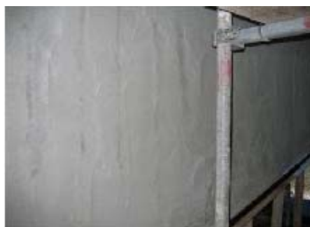
【補修後（ひびわれ補修）】
