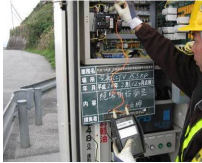
【電気設備点検 (道路施設監視カメラ)】
