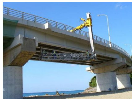
【橋梁点検車による点検】
