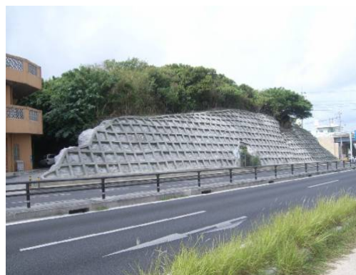
【対策後（落石対策）】
