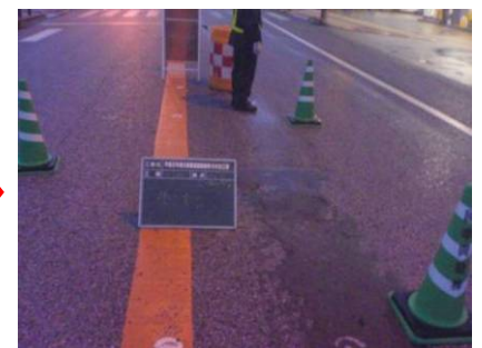
【補修後（一部打替え）】
