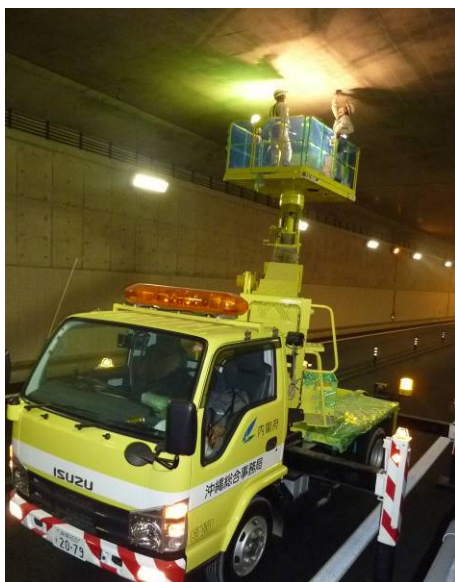
【トンネル点検車による点検】
