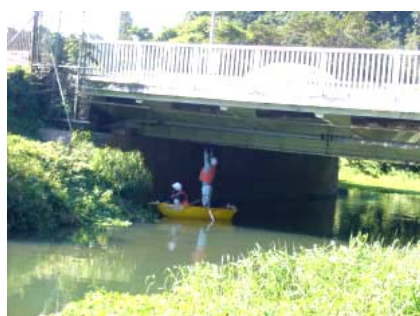
【船上からの点検】
