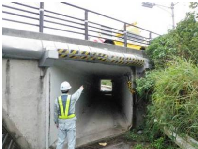
【定期巡回（横断管渠）】
