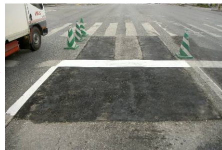
【わだち補修後】
