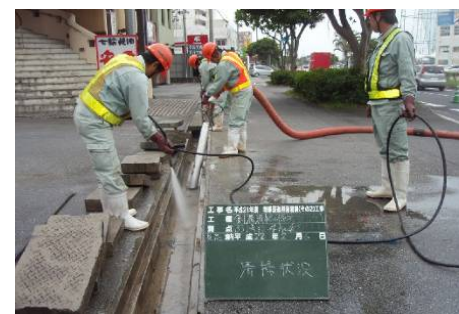
【側溝の清掃状況】
