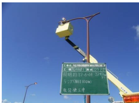
【道路照明灯ランプ交換状況】
