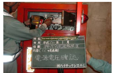
【トンネル非常用施設 (非常用電話) 点検状況】
