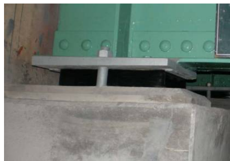
【補修後（支承の交換）】
