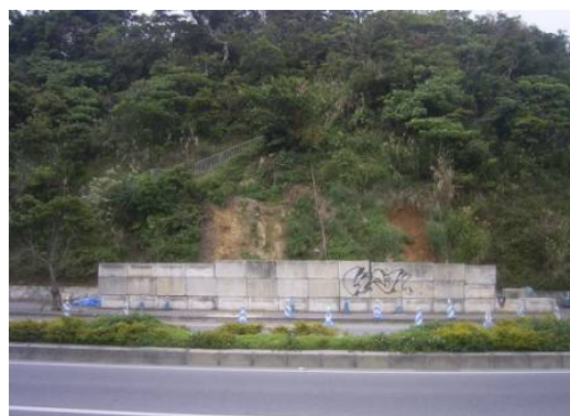
【応急復旧状況】
