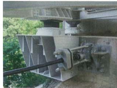
【対策後（落橋防止装置の設置）】
