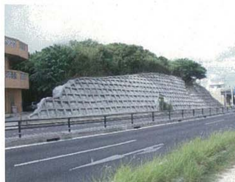
【対策後（落石対策）】
