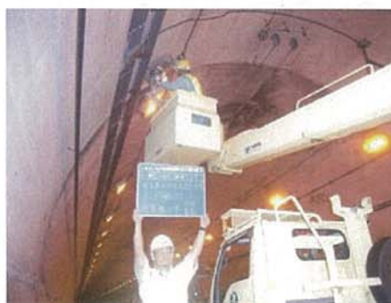
【トンネル照明ランプ交換状況】
