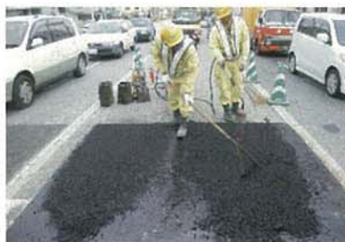
【補修作業状況】
