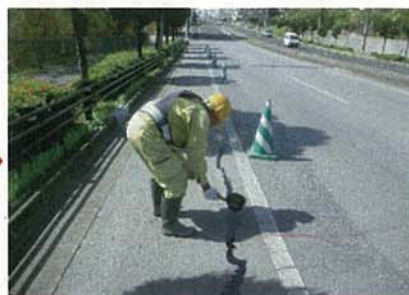
【補修作業状況】
