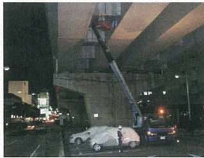
【高所作業車による点検】
