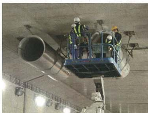
【トンネル非常用施設 (換気設備) 点検】
