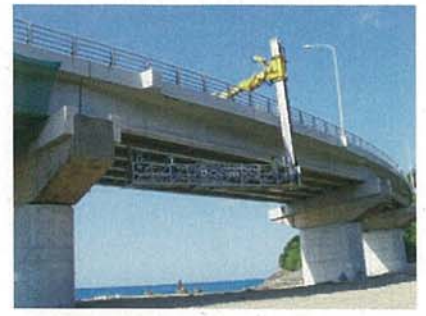
【橋梁点検車による点検】
