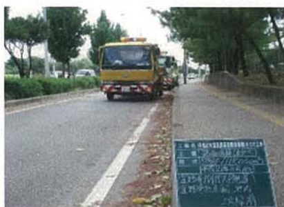
【道路沿いの 清掃状況（清掃前）】
