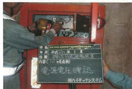
【トンネル非常用施設 (非常用電話) 点検状況】
