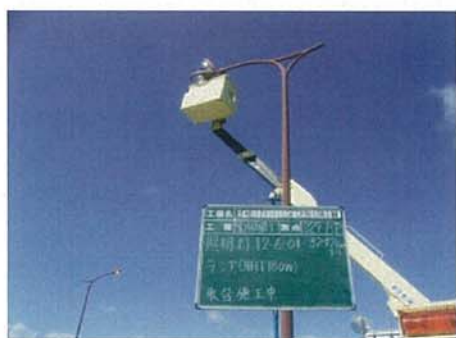
【道路照明灯ランプ交換状況】
