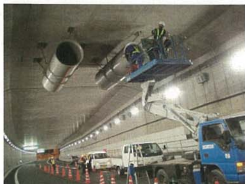
【トンネル非常用施設 (換気設備) 点検】
