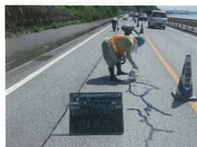
【補修後（注入完了）】
