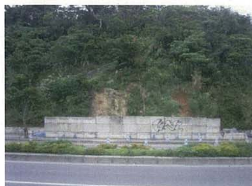
【応急復旧状況】
