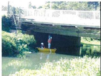
【船上からの点検】
