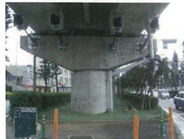
【対策後（コンクリート巻き立て ＋落橋防止装置）】
