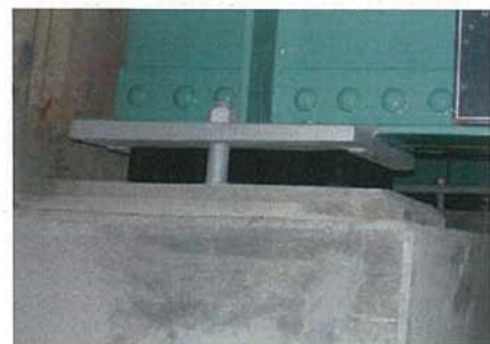
【補修後（支承の交換）】
