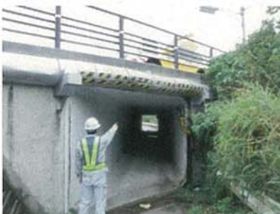
【定期巡回（横断管渠）】
