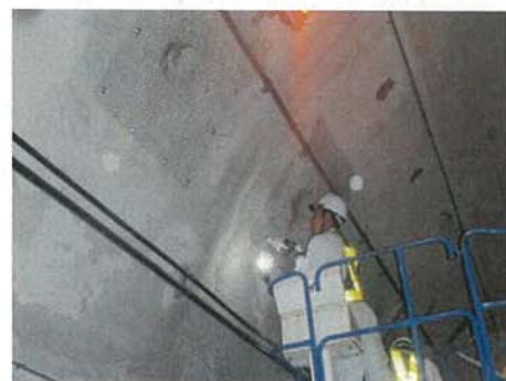
【補修後（対策実施）】
