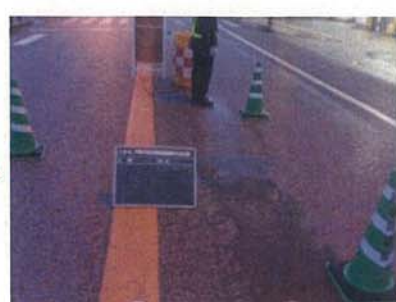
【補修後（一部打替え）】
