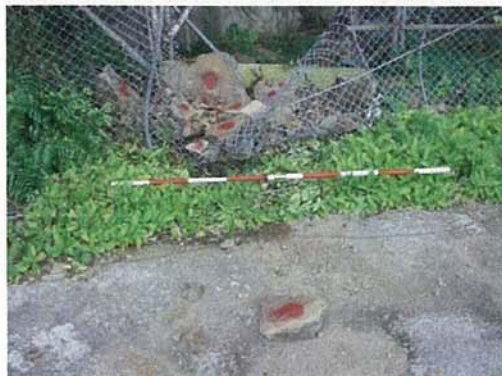
【法面転石の点検】
