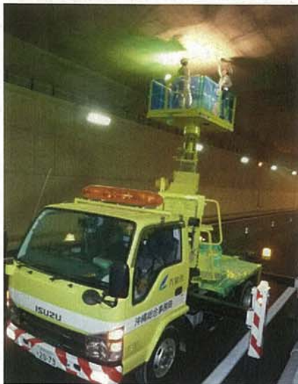
【トンネル点検車による点検】
