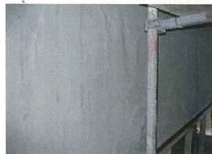
【補修後（ひびわれ補修）】
