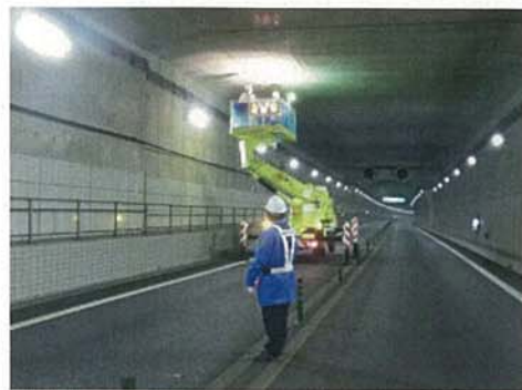
【トンネル点検車による点検】
