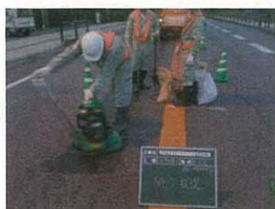
【補修作業状況】
