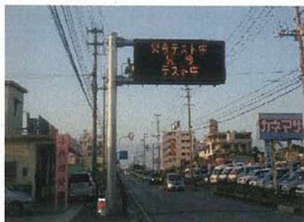
【道路情報板点検状況】
