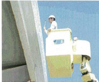
【コンクリート落下事故 防止のための点検】
