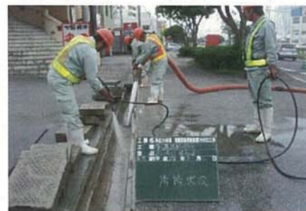
【側溝の清掃状況】
