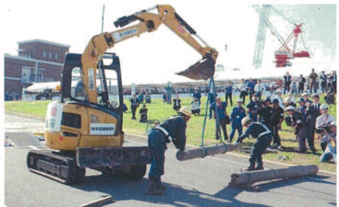
倒壊電柱の撤去
