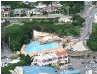
▲ ①落石による通行止め (H20. 6～H21. 2)
