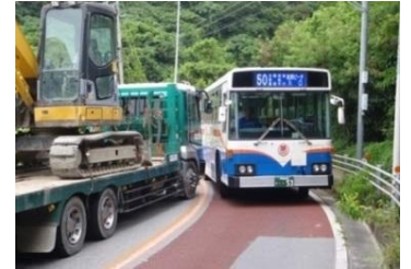
▲ 線形不良による大型車のすれ違い状況
