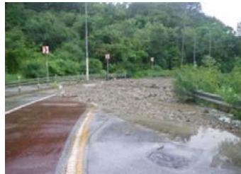
▲ ②土砂流出による通行止め (H23. 11)
