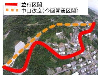
▲ 線形不良の状況
