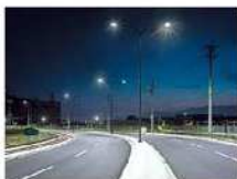
LED照明 (消費電力約56%削減)
