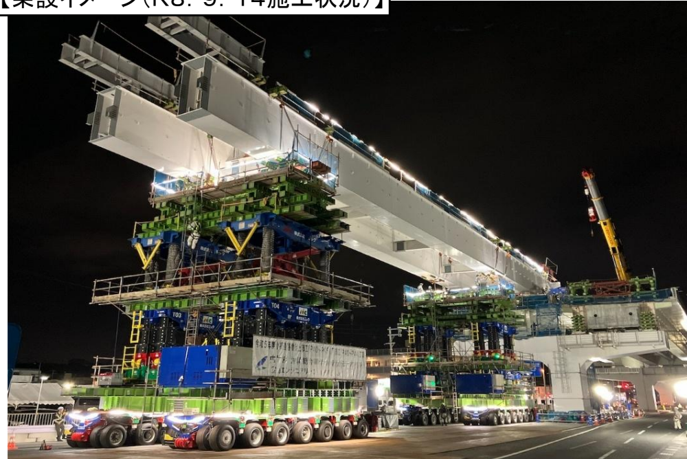
【架設イメージ(R8. 9. 14施工状況)】
