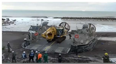
国土交通省の重機等を揚陸
