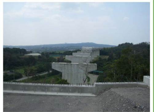
恩納南BP 3号橋 A1～P5望む
