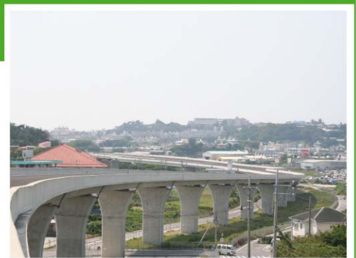
豊見城高架橋 施工状況
