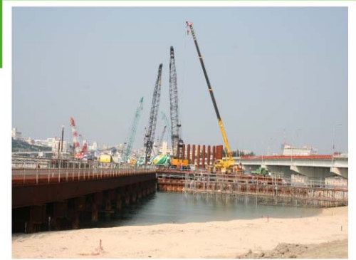
若狭高架橋 施工状況
