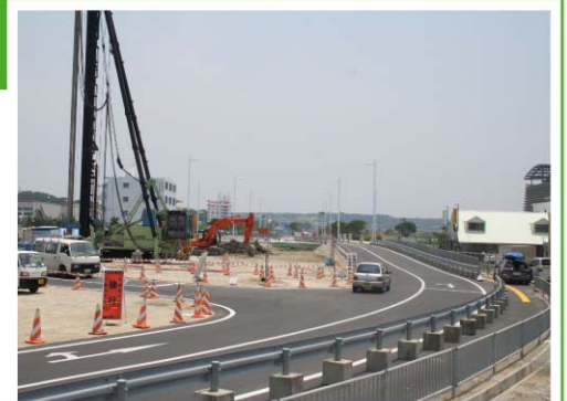
糸満地区地盤改良施工状況
