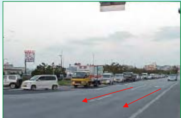
施工後（直進車両がスムーズに通れる）
