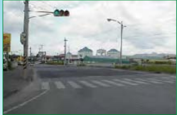
施工後（路面と橋の段差をなくした）
