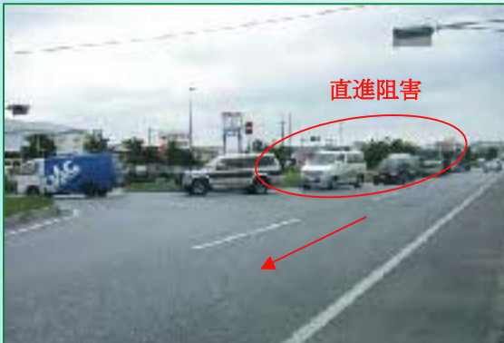
施工前（右折車が直進車両を阻害）
