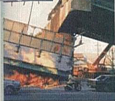
写真. 阪神高速道路の落橋 (西宮市浜脇町)
