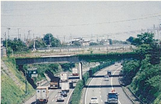
写真. 高速道路をまたぐ橋梁
