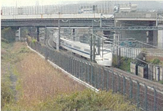
写真. 東海道新幹線をまたぐ橋梁
