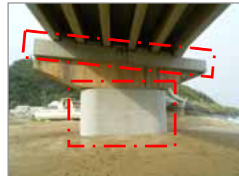
橋梁の耐震補強（大宜味村）
