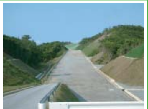
恩納南BP2号 跨道橋より 起点側を望む
