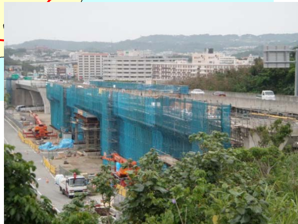
豊見城東道路 (完成4車化整備中の東風平高架橋)
