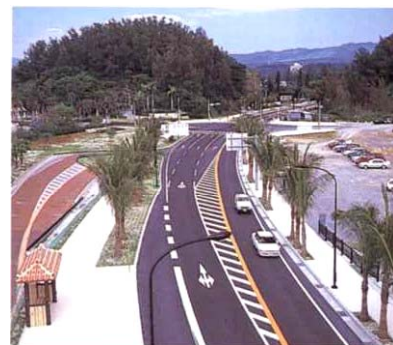
図 幅広歩道整備
