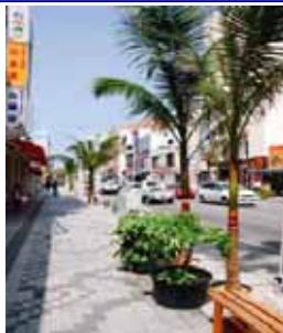
国際通りバリアフリー化 (那覇市美栄橋地区)
