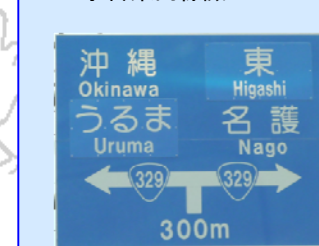
No.2: 予告案内標識
