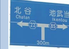
No.2予告案内標識
